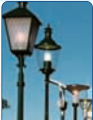
Lichtstraße und Umspannwerk Wels Ost
